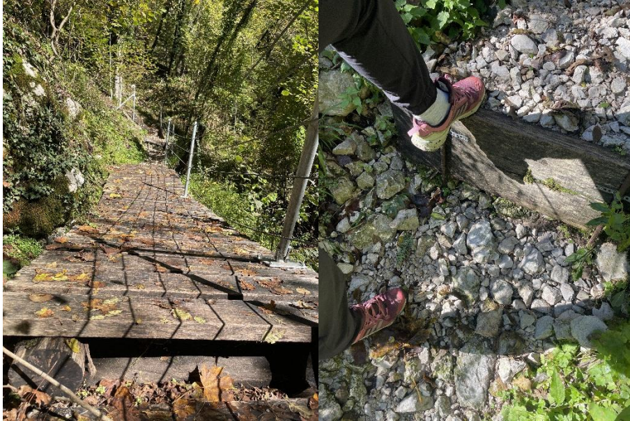
Slika 1: nagibajoč se premostitveni podest s prenitimi temelji
